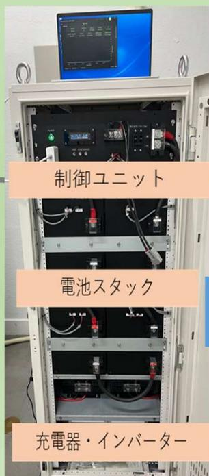
①AC切替器搭載なので商用電源がそのまま負荷機へ供給
