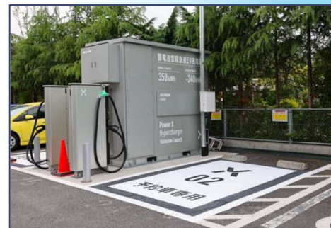
パワーエックス社の蓄電池とEV充電器設置事例
